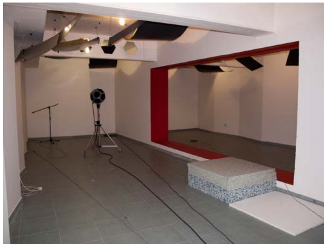
Cámara Reverberante Cámara de Transmisión
